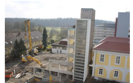
Abrissarbeiten des D-Baus der Rosentrittlinik im Febr. 2015
