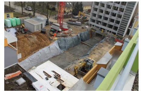
Bauarbeiten der Mall im Jan. 2015
