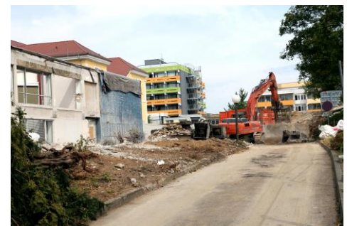
Vorbereitungsarbeiten für den Neubau der Sophie-Luisen-Klinik
