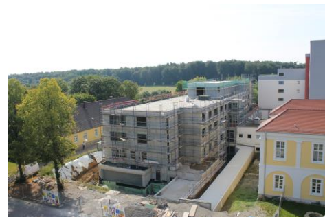
Fortschritte beim Neubau (Stand 16.08.16)
