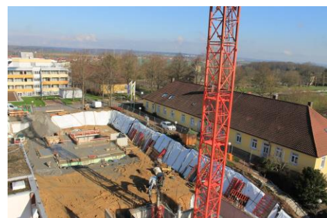
Fortschritte beim Neubau
